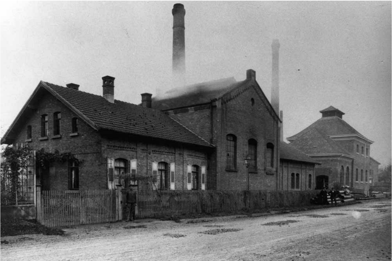
Abb. 6.6.2: Die als Backsteinbau errichteten Gaswerksgebäude Feuerbach (1907).
