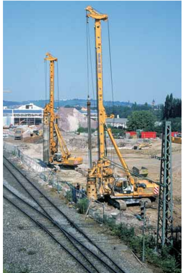
Abb. 7.2.6: Großlochbohrungen im Bereich der Dichtwand (1995).
