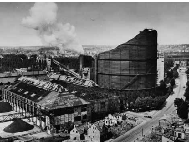
Abb. 6.1.8: Gasometer Stuttgart-Ost (Gaisburg), durch Kriegseinwirkungen zerstört (1945).
