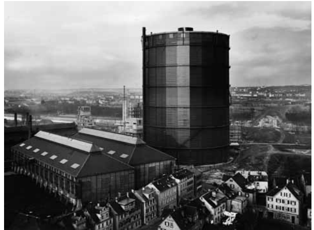
Abb. 6.1.7: Gasometer Stuttgart-Ost (Gaisburg) kurz nach der Fertigstellung (1928).
