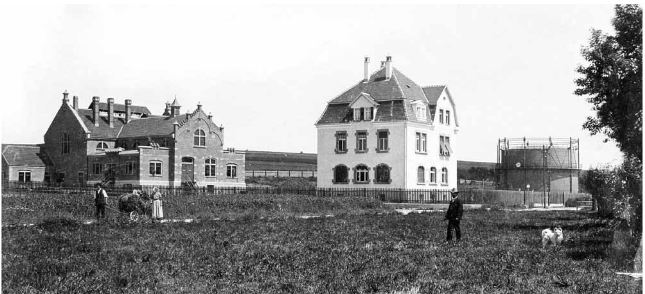
Abb. 6.8.2: Das Gaswerk Zuffenhausen um 1915.
