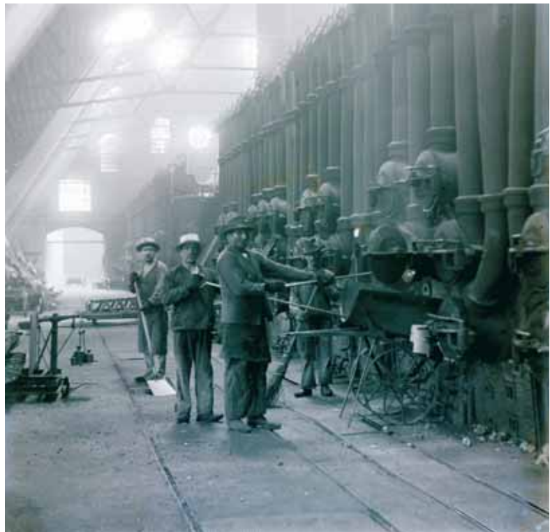
Abb. 1.4: Entleeren der Retorten von Hand im alten Ofenhaus (um 1900).
