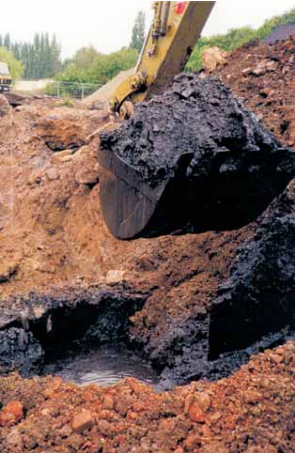
Abb. 7.2.5: Bodenaustauschmaßnahmen im Bereich einer Teergrube (19.05.1995).
