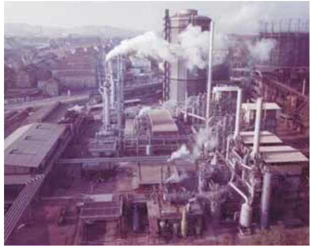
Abb. 6.1.10: Gaswerk Stuttgart-Ost (Gaisburg) (1970).
