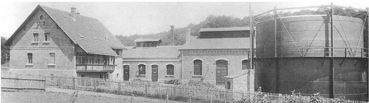
Abb. 6.5.1: Das Gaswerk Degerloch im Jahr 1906 vom heutigen Rüsternweg aus gesehen (v. li.): Verwaltergebäude, Gaswerk in der ursprünglichen, eingeschossigen Bauweise und Gasometer.
