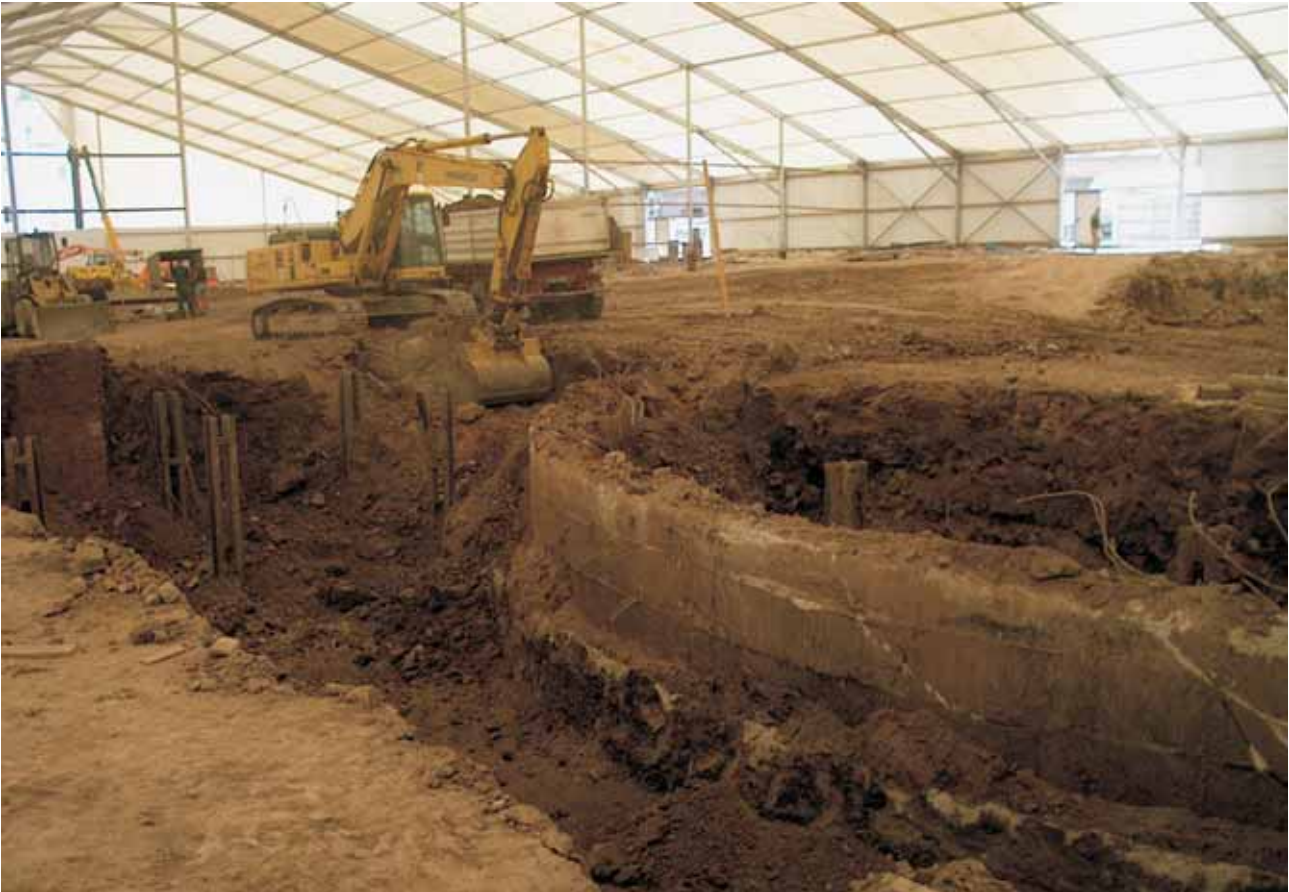
Abb. 6.2.4: Sanierung des Gaswerks Stuttgart-West (Seidenstraße).
