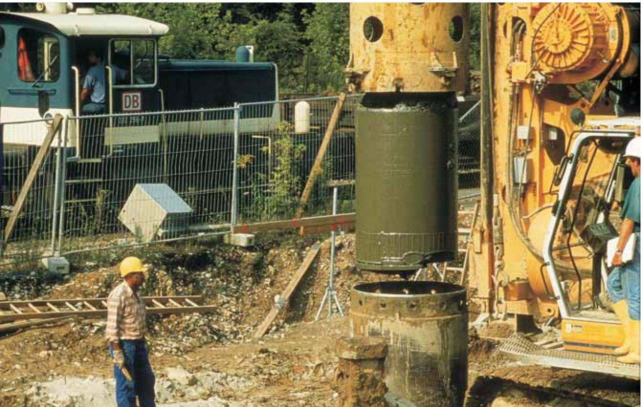
Abb. 7.2.7: Großlochbohrung mit 120 cm Durchmesser (1995).
