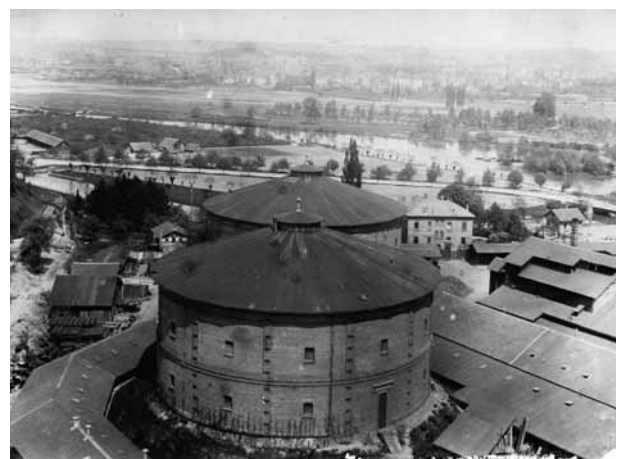
Abb. 6.1.3: Ansicht Gaswerk Stuttgart-Ost (Gaisburg) nach NW (um 1880).
