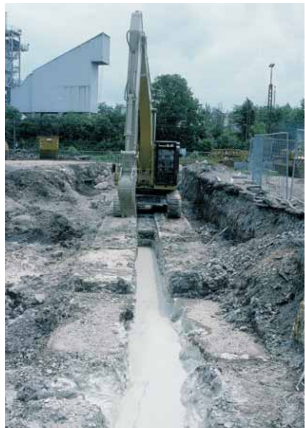
Abb. 7.2.4: Herstellung der Dichtwand 1995.
